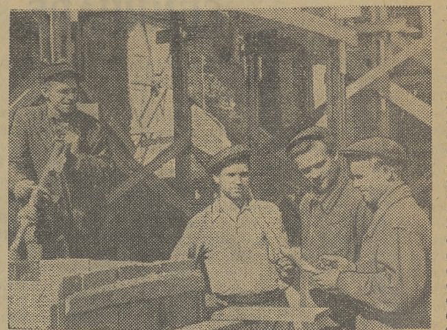
На снимке: (слева направо): бетонщики И. Е. Иконников, В. В. Карташов, Л. Н. Целищев и помощник бригады Н. И. Бондаренко.
