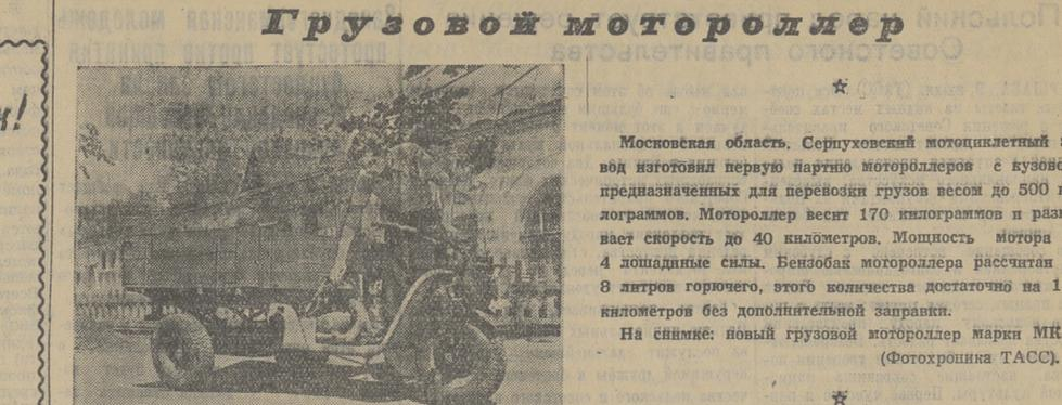
Московская область. Серпуховский мотоциклетный завод изготовил первую партию мотороллеров с кузовом, предназначенных для перевозки грузов весом до 500 килограммов. Мотороллер весит 170 килограммов и развивает скорость до 40 километров. Мощность мотора — 4 лошадиные силы. Бензобаки мотороллера рассчитаны на 8 литров горючего, этого количества достаточно на 150 километров без дополнительной заправки.
