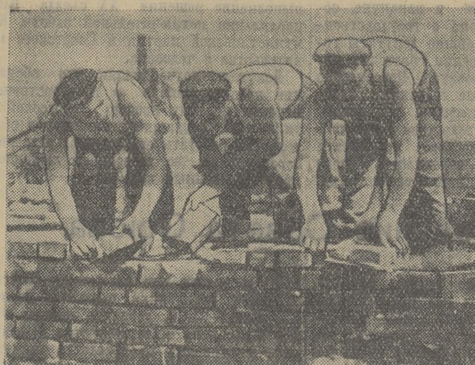
Хорошо трудятся в коллективе строители стропуравления ГРС-21 каменщики бригады тов. Журневича. На снимке: (слева направо) каменщик тов. Еремин, подсобный рабочий тов. Петров и каменщик тов. Алтухов за работой. Они выполняют за смену до двух норм.
