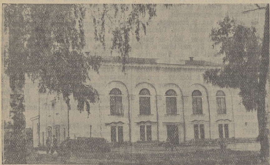
Здание клубной столовой политехнического института, представляющее строителям УНР-768 и сдаче в эксплуатацию.
