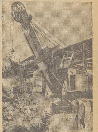
СВЕРДЛОВСК. На Уральском заводе тяжелого машиностроения собрана первая партия новых землеройных машин типа «ЭК-4». Этот экскаватор в отличие от «СЭ-3» более производительен, он имеет ковш емкостью 4 кубометра, стрелу новой конструкции. Гидравлическая система управления тормозами заменена пневматической. Усовершенствована ходовая часть экскаватора, применены траки коробчатого сечения, позволяющие улучшить эксплуатационные качества машины. На снимке: новый экскаватор «ЭК-4». (Фотохроника ТАСС).
