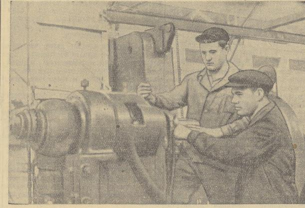
Для повышения выпуска продукции в штамповочном цехе завода «Сибэлектромотор» устанавливается 60-тонный пресс АТ-60. На снимке: слесари-сборщики тт. Ткаченко (слева) и Абрамов за монтажом пресса. Фото Э. Стойлова.
