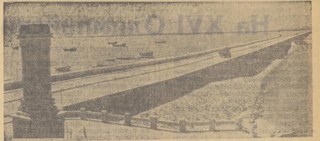
Китайская Народная Республика. Закончено строительство 2-километровой насыпи, соединяющей острова Самьяндао с материком. Ширина насыпи 19 метров. По ней уже началось движение машин и пешеходов. Завершается сооружение и другой насыпи, параллельной первой. По ним пройдет железнодорожная магистраль, которая соединит острова Самьяндао с крупным портом Амои (Юго-Восточный Китай).
