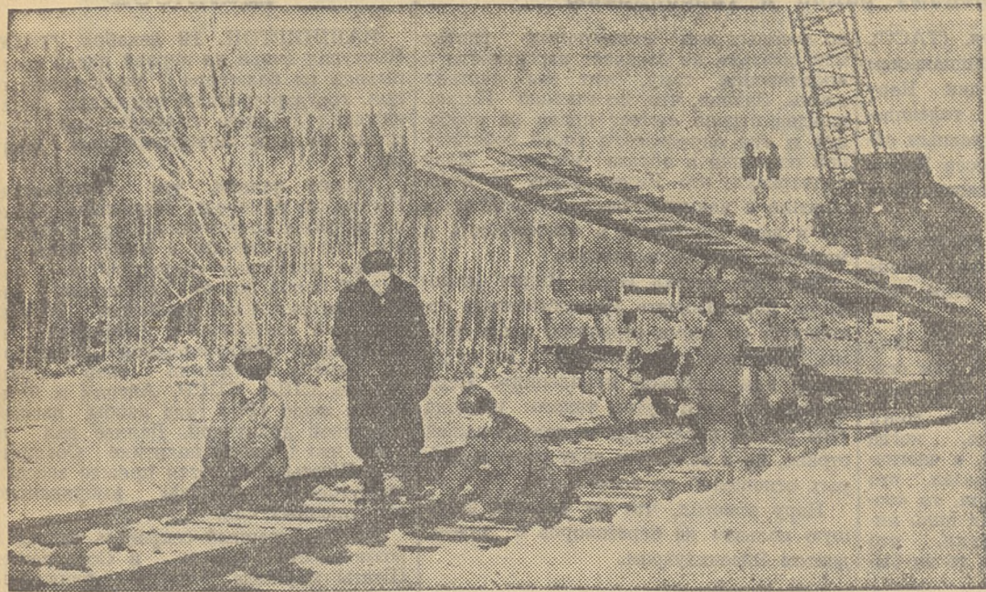
Кемеровская область. Широким фронтом развернулось строительство новой железнодорожной магистрали Сталинск — Абакан. Длина ее свыше 360 километров. По этой дороге будет подвозиться руда на Кузнецкий металлургический комбинат и вывозиться уголь с нового Томско-Усинского месторождения. Строительство ведется в двух направлениях — со стороны Сталинска и со стороны Абакана. Строительство дороги Сталинск — Абакан будет закончено в 1957 году. На снимке: укладочная машина. (Фотохроника ТАСС).
