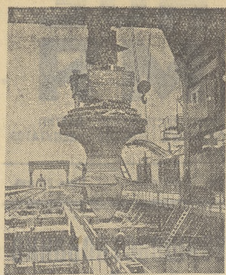
Молотовская область. В кратер агрегата установлена 23-я, последняя вертикальная турбина Камской гидроэлектростанции.
