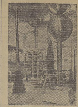
Москва. Испытательная станция — один из важнейших участков производства на заводе «Изолятор». Здесь испытываются все крупногабаритные маслонаполненные изоляторы, выпуск которых налажен на заводе. На фото: электропередачи и трансформаторы строящихся гидроэлектростанций, ведутся исследования электрической прочности высоковольтных изоляторов.
