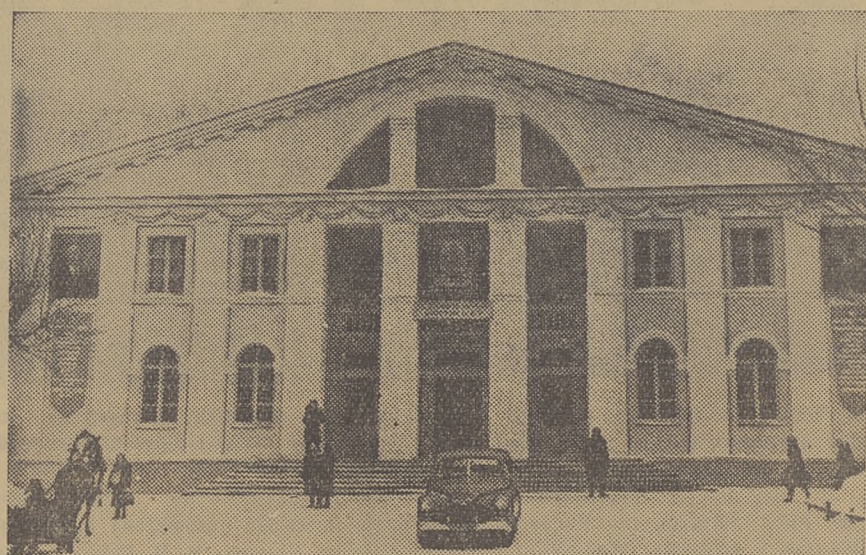
Внешний вид Дома культуры Томского электромеханического завода. Фото В. Асабина.
