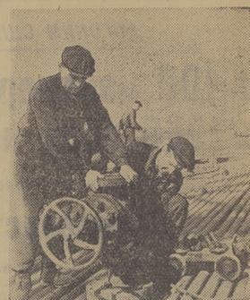
Станиславская область. На Долнинском нефтепромысле скважины в эксплуатации две новые скважины, названные фестивальными. На одной из них — скважине № 118 — на глубине 2.500 метров вскрыт новый нефтеносный пласт. Суточный дебит скважины — 180 тонн жидкого топлива. На снимке: оператор подземного ремонта И. В. Сичка (слева) и помощник оператора В. Ю. Читан монтируют арматуру на скважине № 118.
