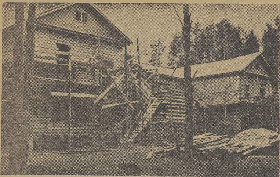
Отдел капитального строительства Тимирязевского леспромпхоза ведет строительство средней школы. Бригада строителей взяла обязательство закончить здание к новому учебному году. На снимке: здание строящейся школы. Фото В. Асабина.
