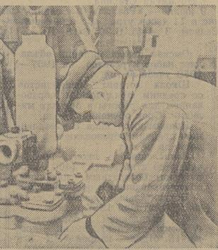
На снимке: буровые рабочие Колпашевской структурно-поисковой разведки Виктор Васильев (слева) и Виктор Белый ведут ремонт насоса буровой вышки, смонтированной на пловучем основании. Фото В. Тананова.
