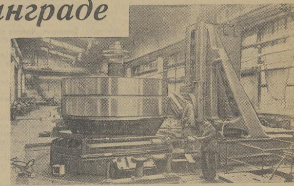
Ленинград. Кировский завод приступил к изготовлению главных двигателей для сухогрузных судов водоизмещением 17 тысяч тонн. Главный двигатель состоит из паровой турбины
