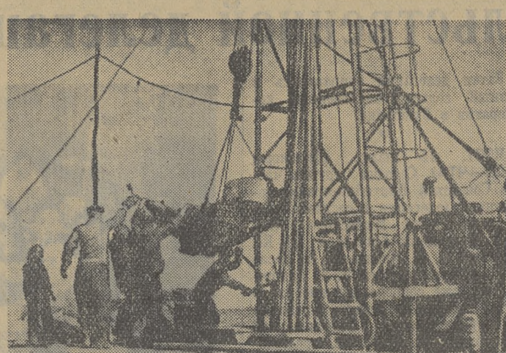
В Бакчарскую поисково-разведочную партию поступило дополнительное оборудование для буровых вышек. На снимке: буровики бригады старшего мастера А. И. Бондаренко срубают с помощью лебедки буровой установки новый насос. Он будет производить промывку скважины глинистым раствором под давлением до 40 атмосфер. Фото С. Блиникова.
