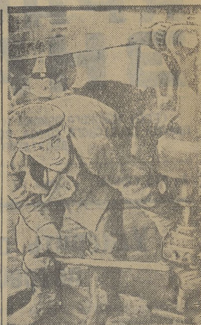
Смена мастера Я. Д. Сазонова Порогнинской буровой бригады Бакчарской поисково-разведочной партии ведет бурение скважины в поисках железной руды. Соревнуясь в честь сорокалетия Октября, буровики дают 130—140 процентов нормы ежедневно. На снимке: сменный мастер Я. Д. Сазонов производит подъем бурового снаряда. Фото Н. Балахонина.
