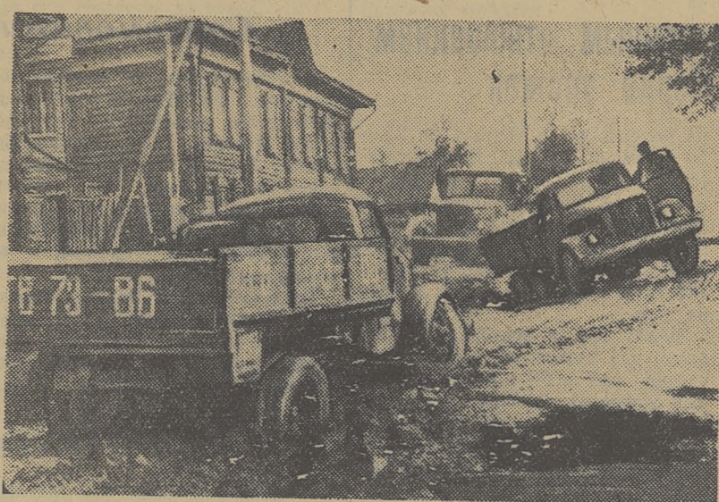
Так выглядит участок дороги на углу улиц Никитина и Тверской. Фото В. Асабяна.
