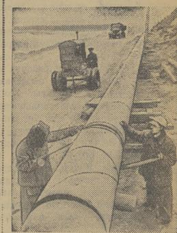
На строительстве Братской ГЭС. Гидростроители ускоряют темпами ведут подготовительные работы по монтажу первой перекачивающей станции мощностью 300 кубометров грунта в час. Вдоль правого берега Ангары на несколько сотен метров протянулись трубы пульпопровода. Работы по монтажу труб и наладке насосов ведет опытная бригада, которую возглавляет Я. И. Редель.
