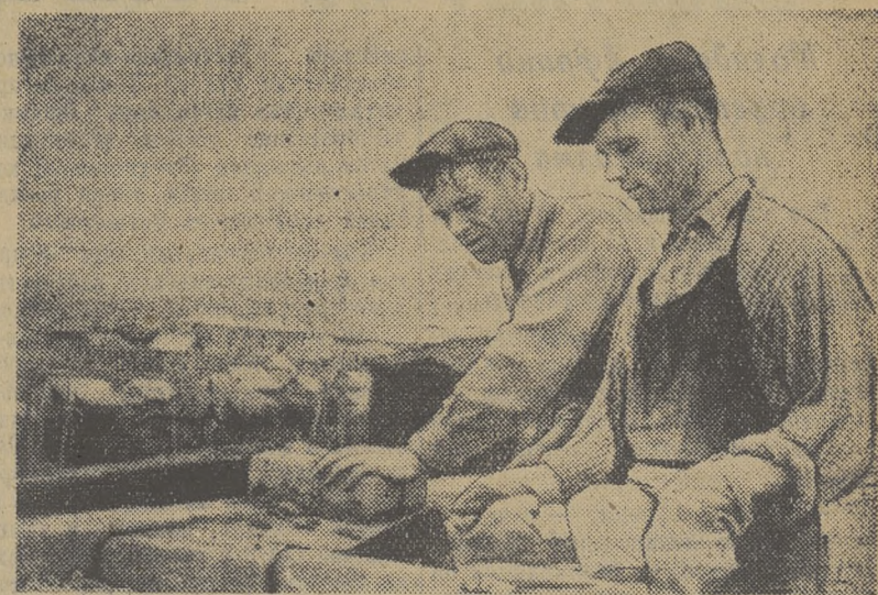
Строительство школы на 880 мест по улице Сибирской (г. Томск). На снимке: передовые каменщики (слева направо) А. М. Бах и А. Г. Вальгер, выполняющие нормы выработки на 150—170 процентов.
