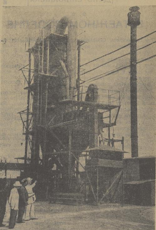
МИНСК. В Институте энергетики Академии наук Белорусской ССР разработан новый метод сушки зерна, основанный на чередовании процессов нагрева и охлаждения. Нагрев зерна производится в потоке горячих газов и протекает 4—5 секунд, т. е. в сотни раз быстрее по сравнению с существующими методами сушки зерна. После каждого прогрева — а их может быть несколько — зерно подвергается охлаждению в потоке холодного воздуха.
