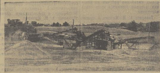
На снимке: дробильно-сортировочный агрегат. Фото Ф. Хитриневича.
