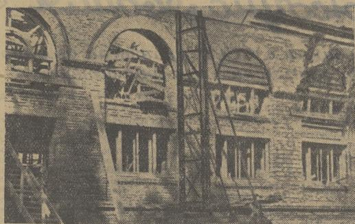
В г. Томске идет сооружение зимнего плавательного бассейна. Фундамент и кладку стен вел коллектив бригады В. А. Крайсмана (трест «Томкстрой»). Сейчас заканчивается железобетонное перекрытие над вторым этажом. Установлены металлические фермы над ванной. Заканчивается подготовка теплоизоляции и кладка устройства канализации. По окончании плотничных и жестяных работ крыши начнут отделочные работы фасада.
