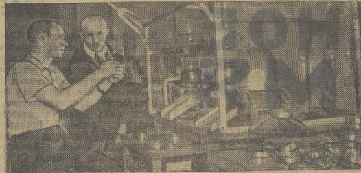
МОСКВА. Инженеры Первого подшипникового завода М. П. Попов и В. В. Кондратов создали автомат для контроля бесшумия в радиальных шарикоподшипниках. Новый автомат заменил труд 8 контролеров и улучшил качество контроля. На снимке: В. В. Кондратов (слева) и М. П. Попов у созданного ими автомата. (Фотохроника ТАСС).
