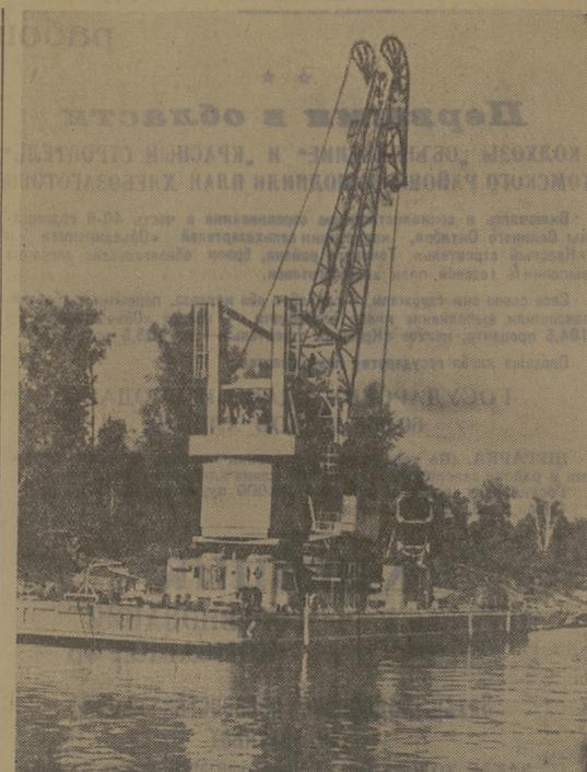
Недавно Красноярский сплавный участок Томской сплавной конторы получил мощный погрузочный кран, который заменит устаревшие лебедки системы Мерлякова. Новый кран значительно ускорит погрузку барж, снизит себестоимость погрузочных работ.
