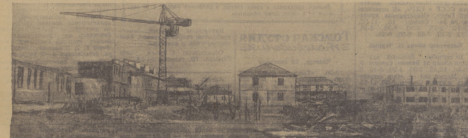
На снимке: общий вид строящегося поселка Томского электромеханического завода.
