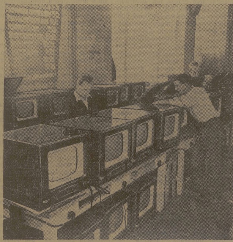
Белорусская ССР. Минский радиозавод начал серийный выпуск телевизоров «Беларусь-3». Новый телевизор состоит из телевизионного приемника, трехдиапазонного радиоприемника, позволяющего принимать станции в диапазонах средних, длинных и коротких волн, и универсального проигрывателя. Размер экрана нового телевизора по диагонали 35 сантиметров. Телевизор «Беларусь-3» имеет дистанционное управление, позволяющее производить настройку на расстоянии до четырех метров.
