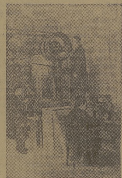
На снимке (слева направо): инженер завода «Томкабель» Г. И. Марголис, инженер-конструктор томского филиала научно-исследовательского института И. И. Синицын и лаборант С. В. Сердцев ведут проверку программных автоматических весов.
