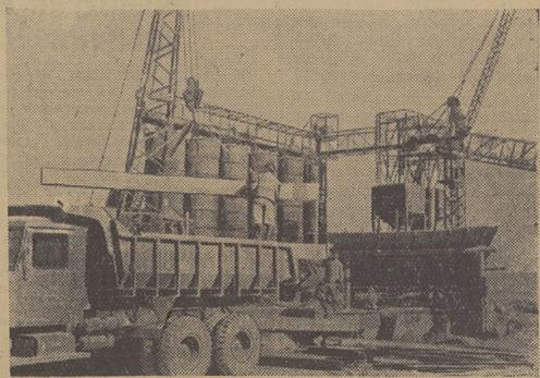
На снимке: отгрузка железобетонных конструкций. На втором плане — железобетонный завод. (Фотохроника ТАСС).
