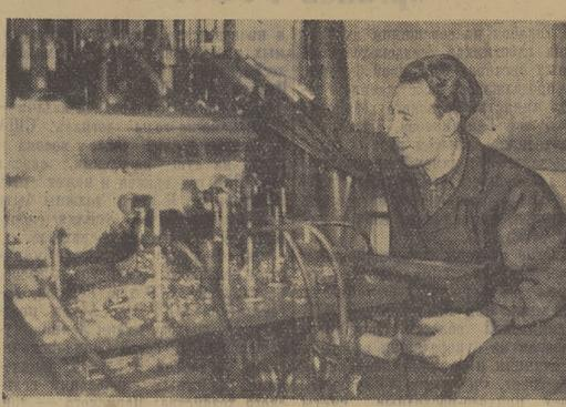
поступает на следующий участок. Там пламя ровненько срезает трубку, и она снова спускается, а готовые колбы поступают в бункер.
