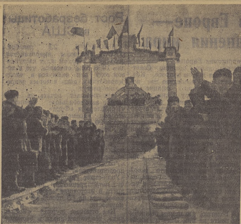
Строители новой железнодорожной линии Сталинск — Абакан в трудных условиях сибирской тайги. Открыт кратчайший путь хакасской руде к домам Кузнецкого комбината. На станции Балыксу, где сошлись участки новой магистрали, состоялся митинг строителей и гостей из Сталинска. На снимке: первый поезд с рудой проходит через памятную арку на станции Балыксу. (Фотохроника ТАСС).
