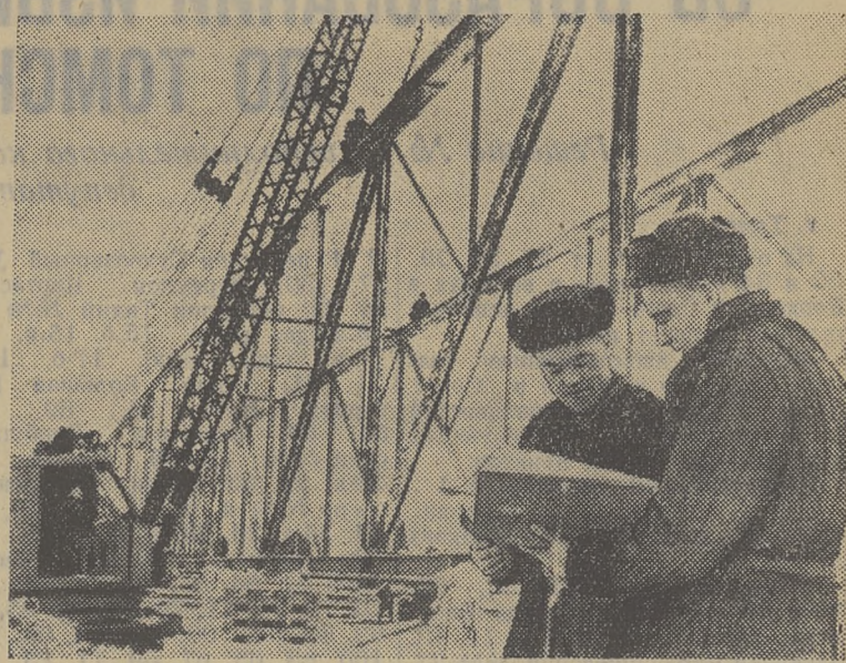
На Томский лесоперевалочный комбинат поступило новое оборудование: три кабельных мостовых электрокрана (перевалочных). Каждый из них длиной 145 метров, высота его — 28 метров. При помощи таких кранов можно штабеловать лес, грузить его на железнодорожные платформы, подавать на раздельные площадки.
