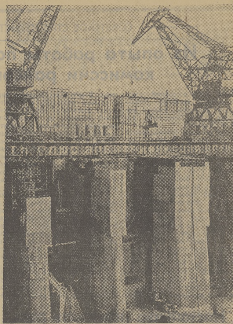
На строительстве Сталинградской гидроэлектростанции. На снимке: вид с рисбермы на бетоновозную эстакаду и здание ГЭС с быками.
