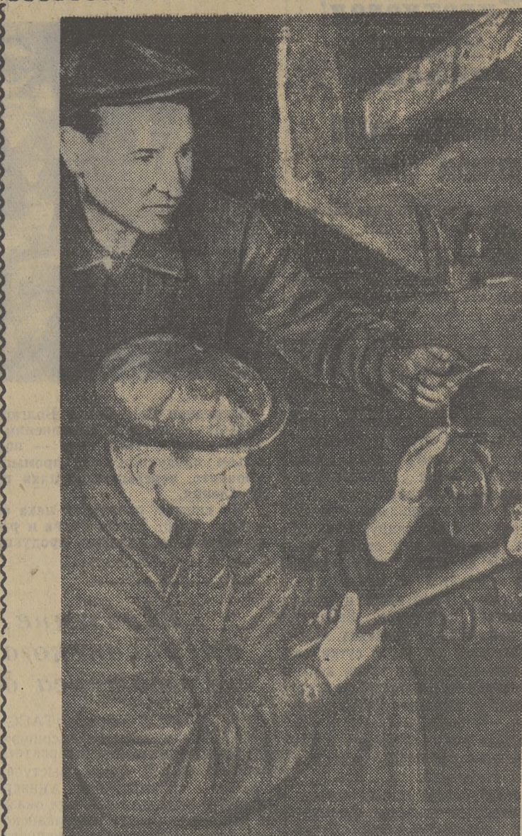
Слесари паровозного депо станции Томск-II Леонид Александрович Прыгин и Иван Петрович Цедрик, работавшие на ремонте паровозов, систематически выполняют свои служебные задания на 180—220 процентов. На снимке (справа): слесарь комсомольской организации паровозного депо станции Томск-II Л. А. Прыгин и И. П. Цедрик за сборкой полувагона. Фото Г. Ткаченко.
