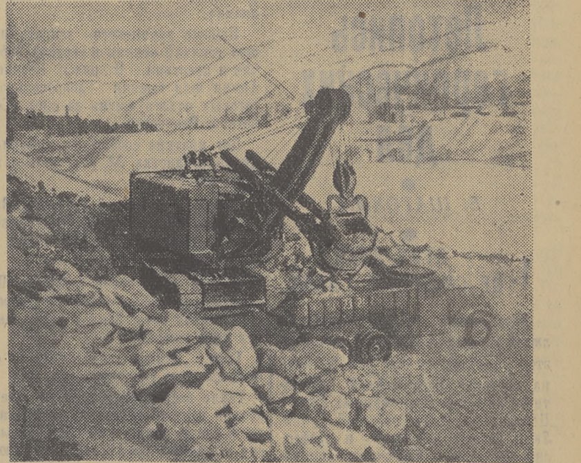
Казахская ССР. Стрелки Бухтарминской ГЭС приступили к новому этапу работ. В левобережном котловане началась очистка дна Иртыша и выемка скального грунта в месте примыкания плотины к скалам левого берега. На снимке: начало работ на дне левобережного котлована. (Фотохроника ТАСС).
