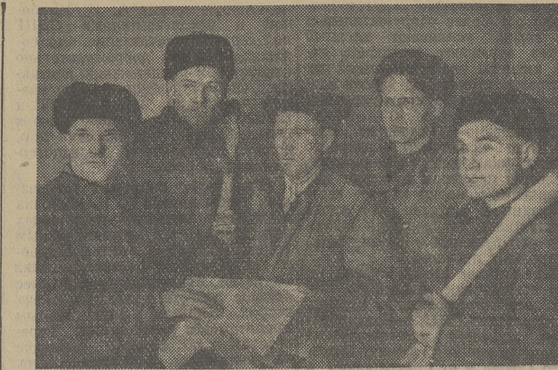
На строительстве 70-квартирного дома для рабочих завода «Томкабель», которое ведет УНР-768, ежедневно перевыполняют нормы бригады плотников, которой руководит тов. Бондаренко. На снимке (слева направо): бригадир тов. Бондаренко, плотники тт. Холдяков, Кривоногов, Иванов, Майданский. Фото Ф. Хитриневича.
