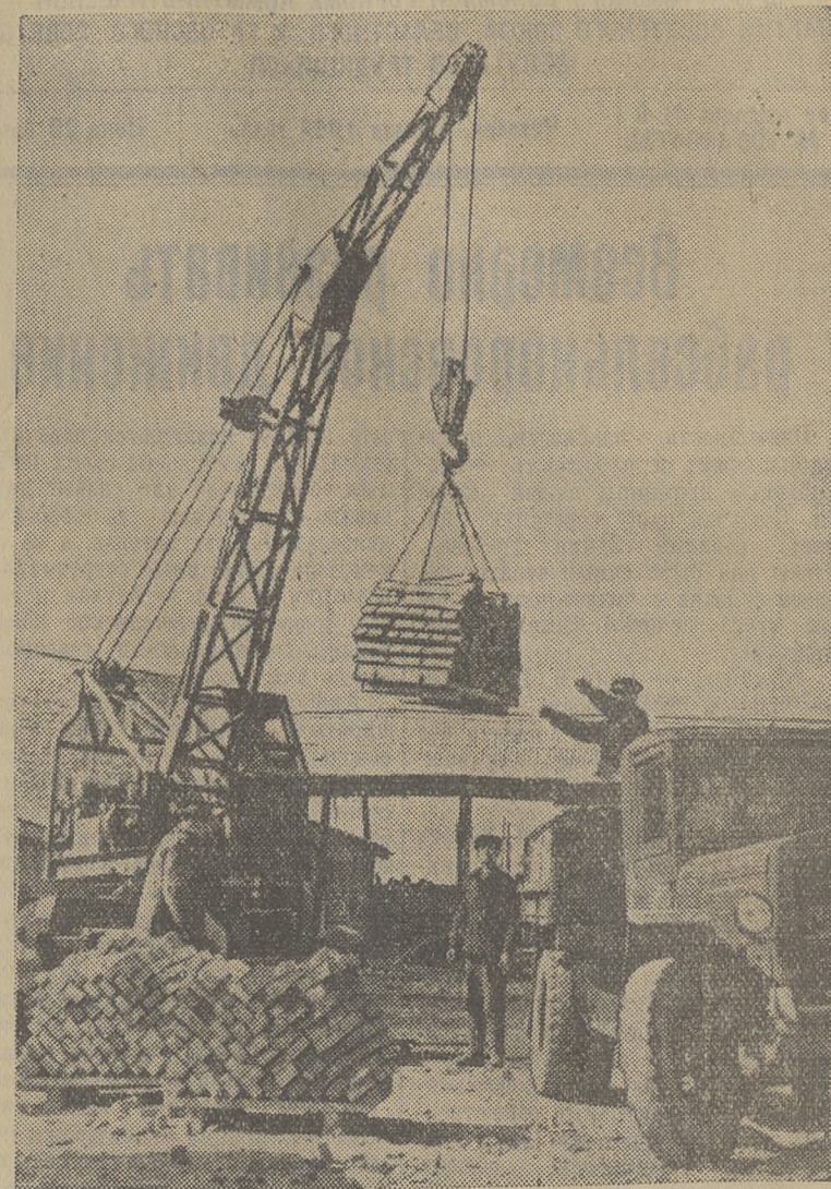
В начале апреля бригады комплексной бригады третьего участка УНР-787 В. Залин призвал строителей начать соревнование за экономично кирпич и предложил перевозить его с кирпичных заводов на стройки в контейнерах или на поддонах. Теперь это предложение осуществлено. Весь кирпич для строек УНР-787 кирпичный завод № 10 отправляет на поддонах. В ближайшее время таким же способом кирпич будет доставляться стройкам ГРЭС-II и «Томскстроя».
