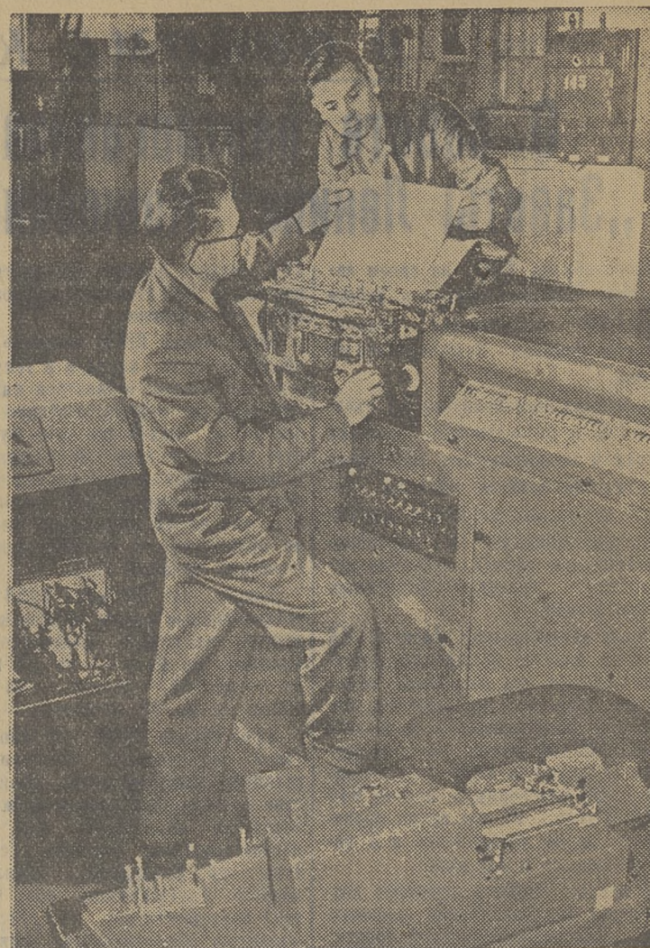
На Московском заводе счетно-аналитических машин изготавливаются табуляторы Т-5-М с перфоратором ИП-80 и специальной электронной приставкой для фабрики механизированного учета, где будет производиться на этих машинах обработка материалов переписи населения СССР. Этот комплект машин позволит быстро и точно обработать данные о переписи населения. На снимке: начальник табуляторного цеха И. Ф. Федотов (слева) и контрольный мастер В. А. Митяев за регулировкой табулятора Т-5-М, перфоратора и приставки. (Фотохроника ТАСС).
