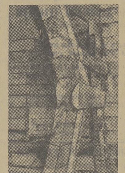
Так выглядят стены и простенки в доме по улице Розы Люксембург № 107, который строят работники ремонтно-строительного треста.
