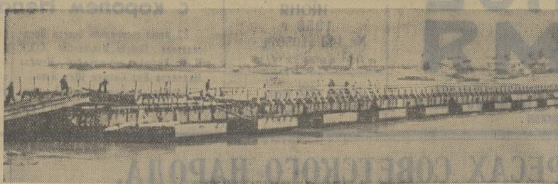
В г. Томске через р. Том установлен новый pontонный мост. Он состоит из 30 металлических понтонов, изготовленных Морской ремонтно-эксплуатационной базой. На сооружение моста затрачено 5 миллионов рублей.
