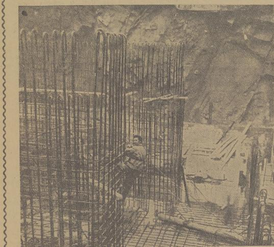
Чехословацкая Республика. В Липно на реке Влтаве (Южная Чехия) строится крупнейшая в стране подземная гидроэлектростанция. Огромный котлован освещен днем и ночью. В течение месяца уложено цемента на 120 тысяч кубометров больше, чем намечалось. Через год будет сдана в эксплуатацию первая турбина Липненской гидроэлектростанции.
