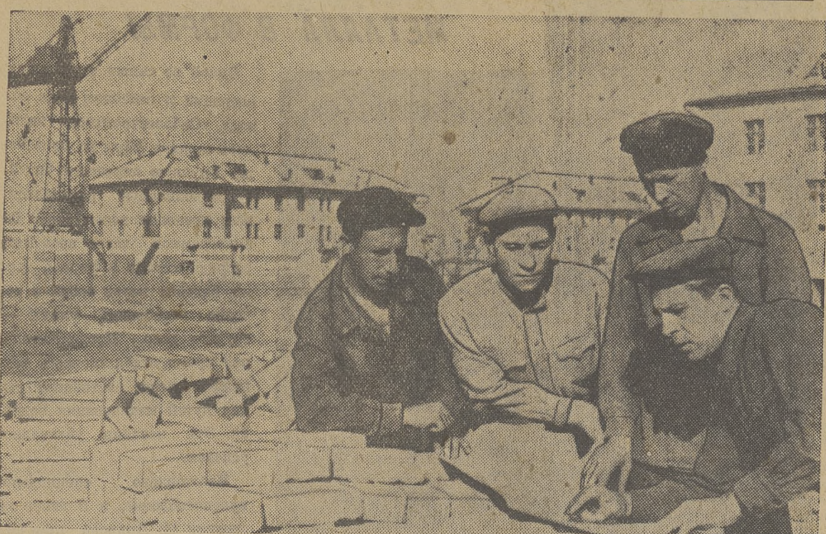
На снимке: бригадир монтажников нулевого цикла УНР-739 М. А. Коржишко (справа) и члены бригады Я. С. Дронов, А. Н. Брытов, В. Е. Даньков.
