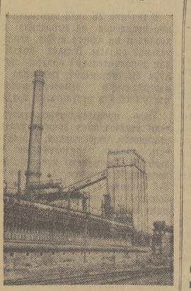
Сталинская область. На Ясновокомском коксохимическом заводе в Макееве введена в действие самая мощная в мире коксовая батарея новой конструкции с комплексом сооружений химического производства. Она состоит из 77 печей емкостью 30 кубометров каждая. Эти печи по своему объему в полтора раза превышают самые крупные печи батарей, действующих в СССР и за рубежом.
