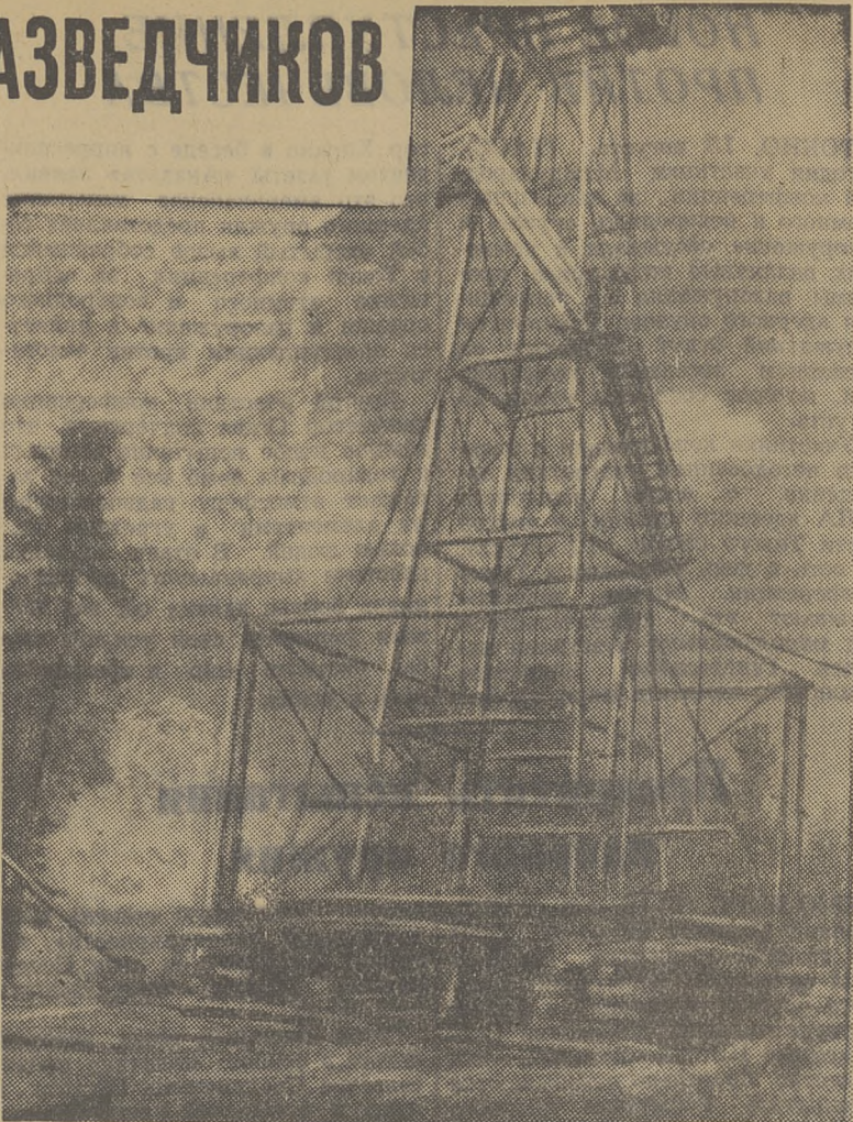
Общий вид строительства буровой Р-4.
