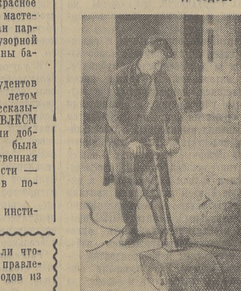
На снимке: мастер В. В. Росенчук обрабатывает строгальную электрическую машину паркетный пол, настланный студентами. Фото Ф. Хитриневича.
