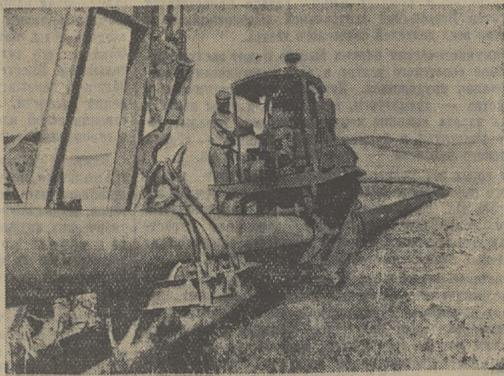
В Чечено-Ингушской АССР сооружается магистральный газопровод протяженностью 63 километра, который соединит новое месторождение нефти Карабулак с городом Грозным. Монтажные уже сварили стальную нитку длиной 31 километр. Изоляционные и укладочные работы в траншее свыше 12 километров труб.
