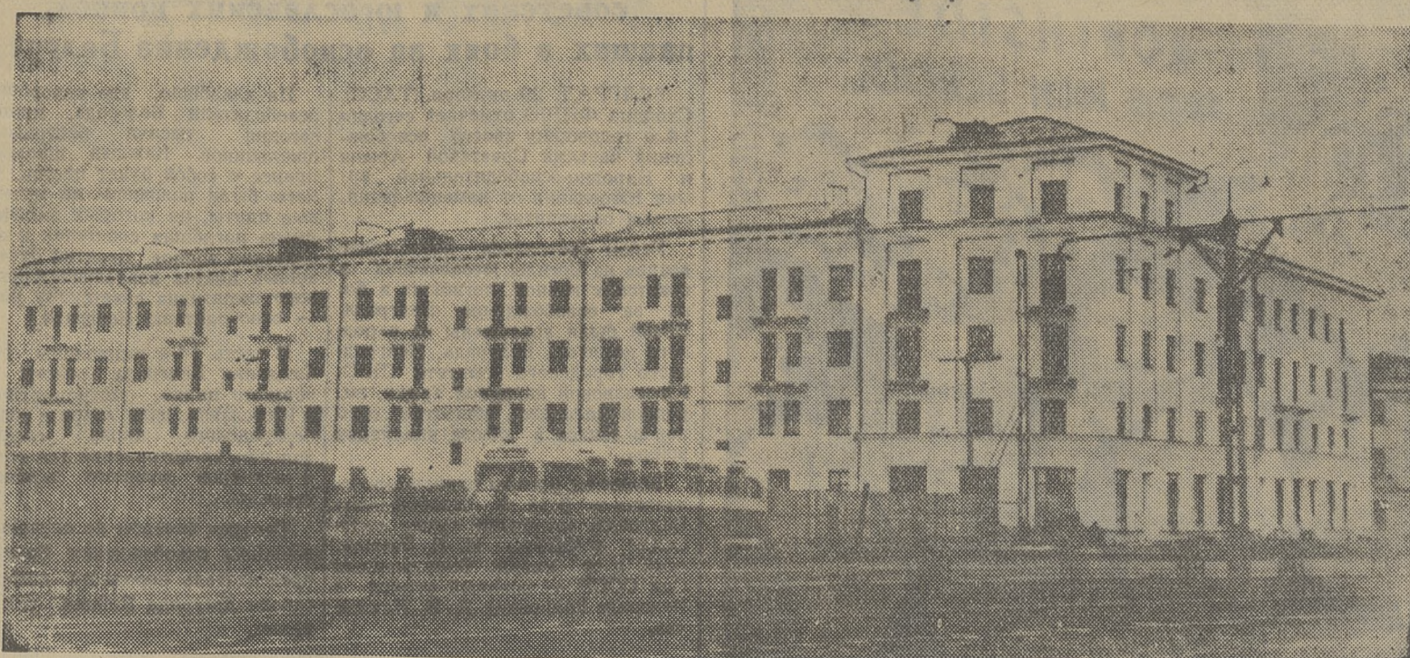
На снимке: строящийся 70-квартирный дом для работников завода «Томкабель» на улице Пушкина. Фото Ф. Хитриновича.
