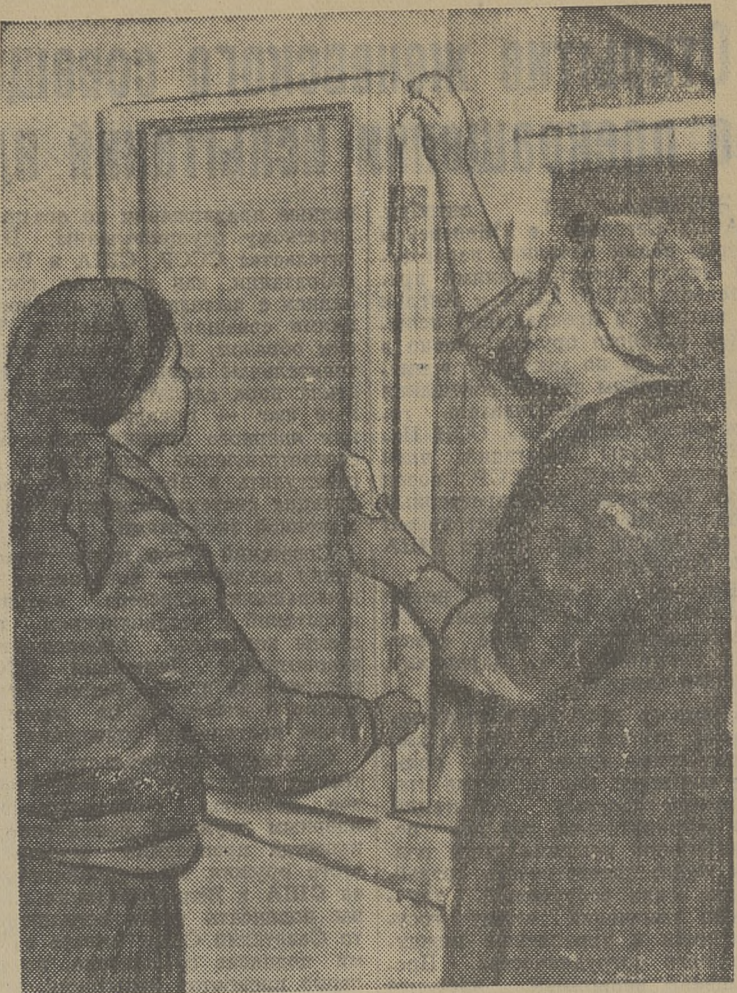
Строители УНР-768 закончили строительство 70-квартирного дома для завода «Томкабель». Сейчас здесь ведутся последние отделочные работы.
