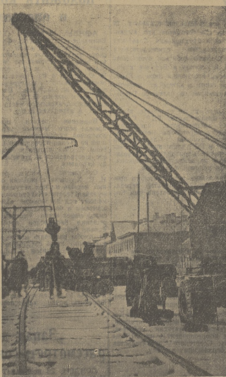
Заканчивается строительство новой трамвайной линии. Работы свяжут центр Томска с рабочим поселком Черемухинки. На снимке: подвеска проводов на новой трамвайной линии. Фото Г. Таченко.
