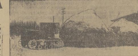
толщиной в 10-12 сантиметров. Одним концом жерди укладываются на поперечки сани. После этого стог зацепляется тросом (4) и затаскивается трактором на сани. Если стога небольшие — по 14-16 центнеров, то на передние сани грузятся 2 стога, а на задние — 1 стог, а если стога по 20-25 центнеров, то на передние и задние сани грузятся по одному стогу.
