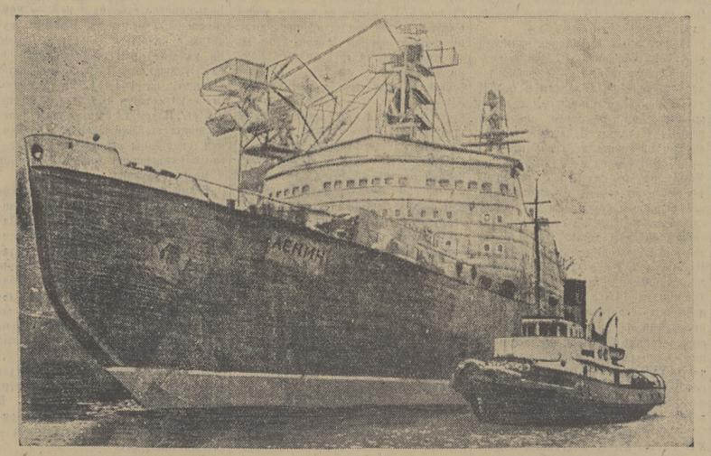
ЛЕНИНГРАД. Строящийся в Советском Союзе первый атомный корабль и крупнейший в мире атомный ледокол «Ленин» проходит швартовые испытания. Стрелки корабля проверяют взаимодействие машин, механизмов, приборов и многочисленных автоматических устройств, обеспечивающих удобство и безопасность работы команды. На снимке: ледокол «Ленин» у пирса завода. (Фотохроника ТАСС).
