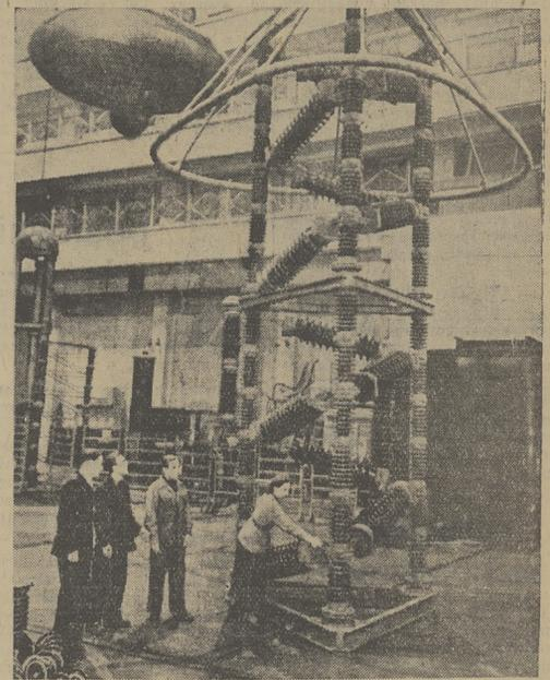
ЛЕНИНГРАД. На заводе «Пролетарий» создан опытный электрический аппарат — разрядник с магнитным гашением, рассчитанный на напряжение тока в полмиллиона вольт. Конструкция этого сверхмощного аппарата высотой десять метров разработана учеными Всесоюзного научно-исследовательского электротехнического института имени В. И. Ленина.
