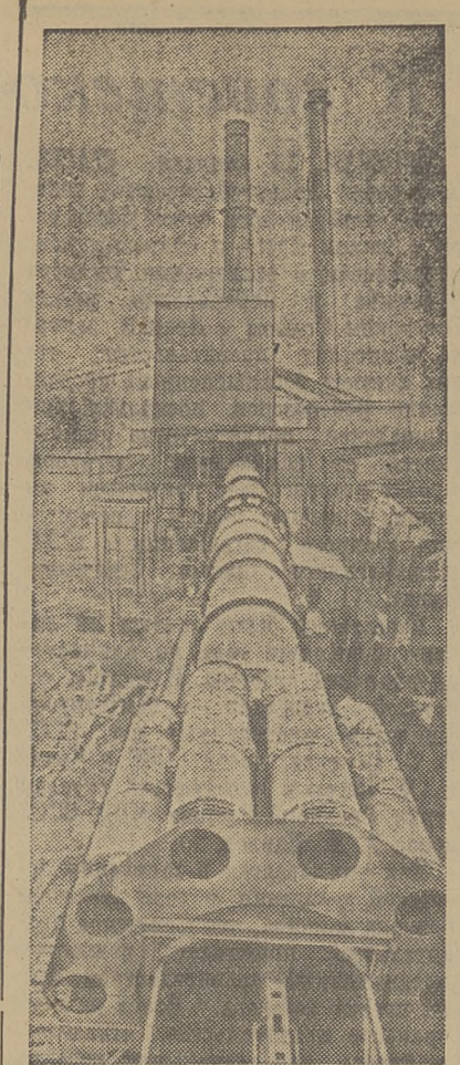
Сталинская область. На Краматорском цементном заводе построена 70-метровая вращающаяся печь. Она оборудована устройством для подготовки сырья, ускорителем и улучшающим прокатывание клинкера. На печи также смонтировано приспособление для улавливания пыли из отходов газов.
