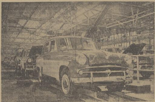
МОСКВА. Конструкторы, технологи и рабочие завода малолитражных автомобилей усовершенствовали и модернизировали ряд узлов машины «Москвич». На усовершенствованном автомобиле модели «407» установлены улучшенные тяги в рулевом управлении, новый акселератор, фильтр воздушной очистки, новый карбюратор и т. д. Автомашини обрешиваются стойкой эмалью в радиусе глаз светловыпуклый, бирюзовый, салатный и другие цвета.
