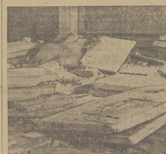
Эти плиты и балки, стоящие более 2.000 рублей, брошены в цех сборного железобетона как ненужный хлам.
