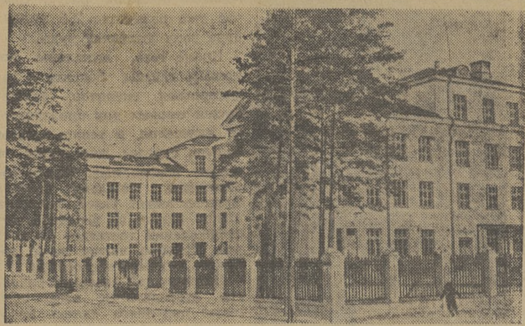
Бурятская АССР. Растет и благоустраивается столица республики — Улан-Удэ. Здесь возводятся жилые и административные здания. Особенно широко развернулось строительство на окраинах, где создаются рабочие поселки различных предприятий. На снимке: здание средней школы-интерната № 2 в поселке рабочих стекольного завода.
