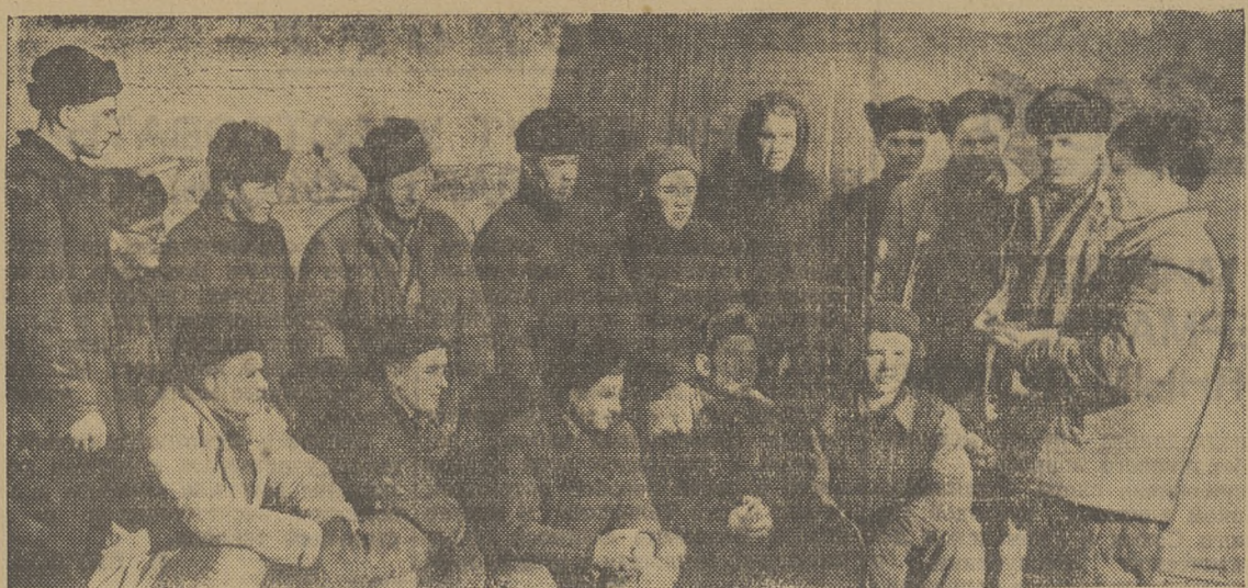
Бригада тов. Вондаренко, занятая на строительстве комбината строительных деталей № 5 (Томск), ежедневно выполняет более двух норм за смену.
